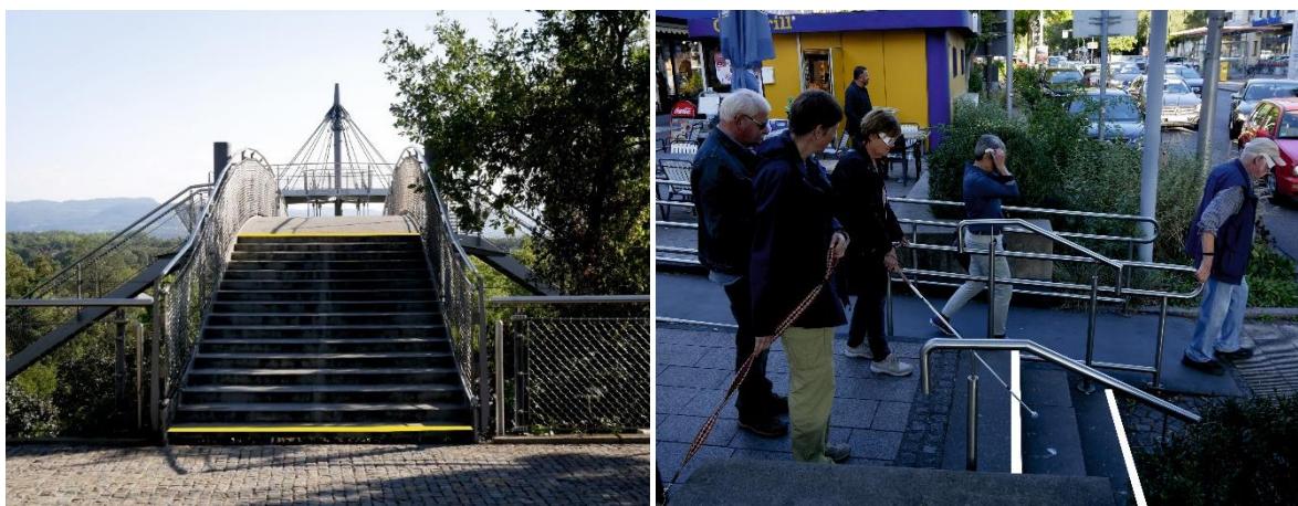
Abbildung 26: Skizze zu fehlendem Kontrast an der Treppe zum Schlaichturm (l.) und vor dem Kaufring (r.)
