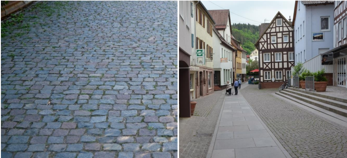
Abbildung 23: Kopfsteinpflaster am Bahnweg (l.) und „Komfort“-Streifen in Calw (r.)
