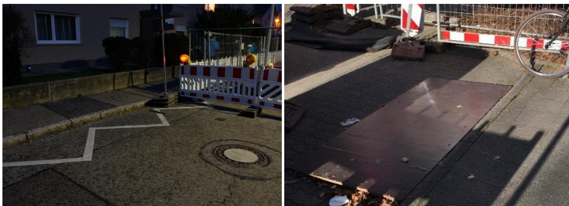
Abbildung 40: Baustelle in der Reblistraße (l.) und Bordsteinabsenkungen an Baustellen in Karlsruhe (r.)
