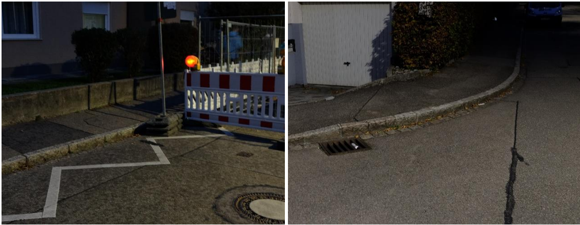
Abbildung 69: keine Borsteinabsenkung an Baustelle, Kreuzung Reblistraße/ Hirschenstraße
