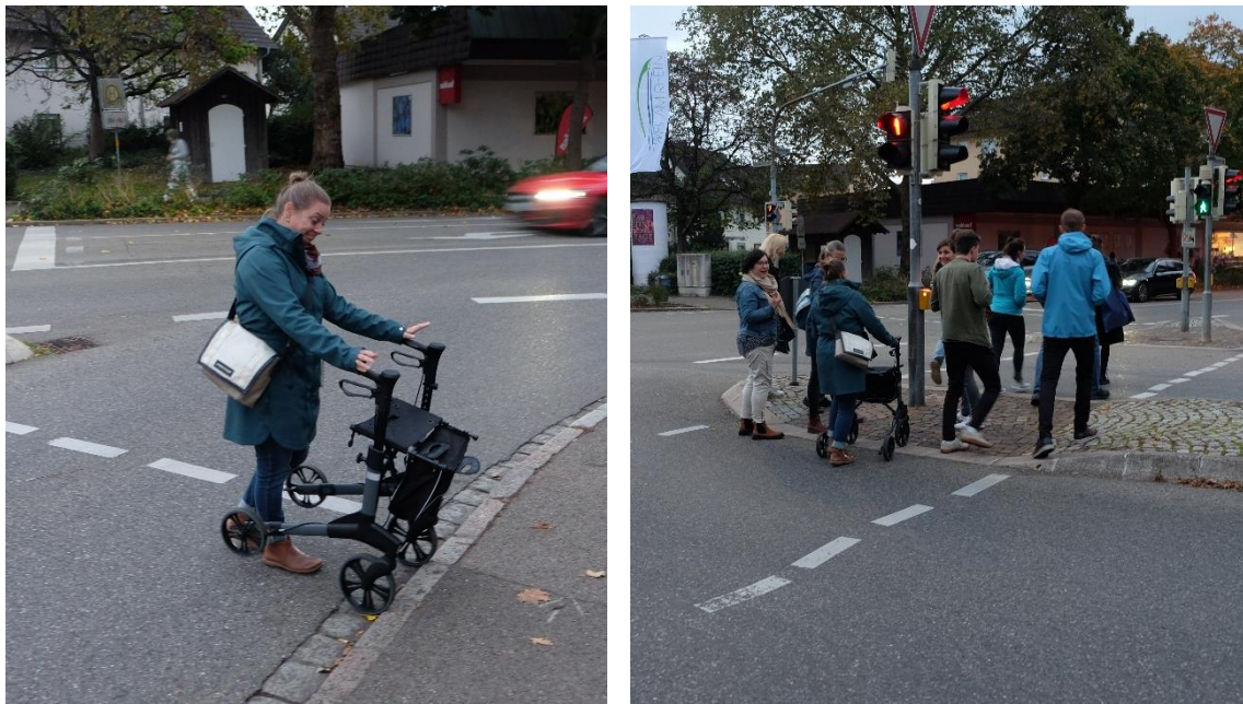
Abbildung 66: Keine Nullabsenkung des Bordsteins, zu klein dimensionierte Mittelinsel
