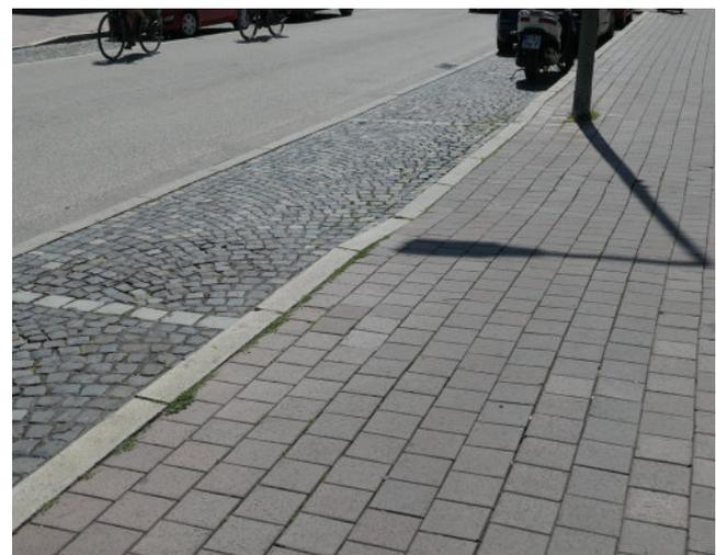
Abb. 55: versickerungsfähiges Pflaster in Freising
